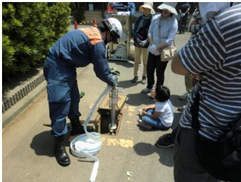
スタンドパイプ
