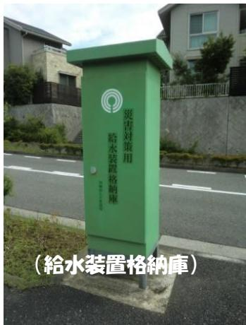
応急給水拠点には、災害対策用給水装置格納庫が設置されています。格納庫には、組立式の応急給水栓や手動ポンプなどの給水器具が入っています。
